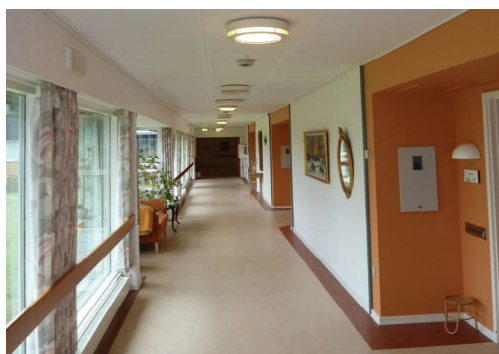
Gangareal med nyrenoverede lamper
