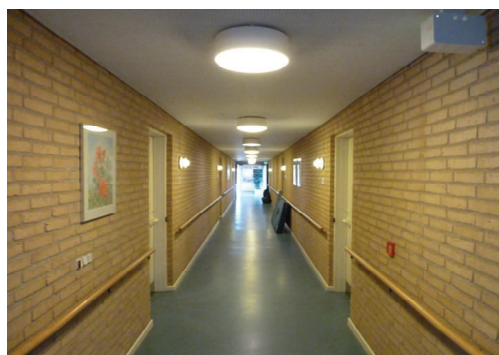
Gangareal med nyrenoverede lamper
