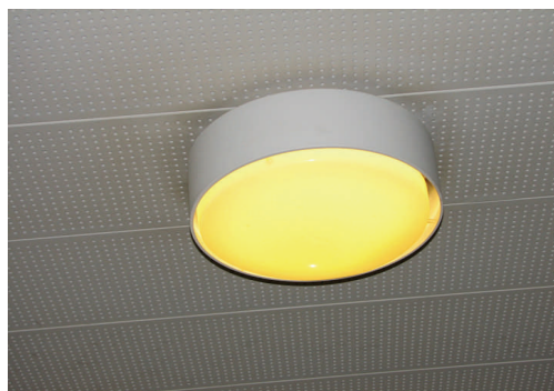
Lyfa før renovering
