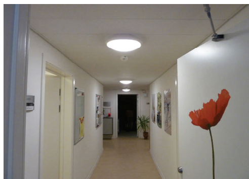
Gang med renoverede Solar loftslamper
